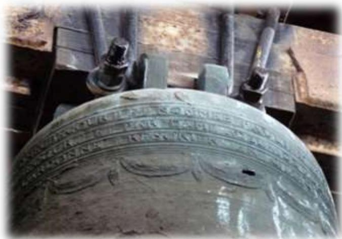
Les deux cloches ont été fondues et coulées en bronze (ou airain terme utilisé pour les cloches); alliage constitué de 78 % de cuivre et 22 % d'étain, alliage très sonore. Une ascension dans le beffroi, entre les poutres permet de lire les inscriptions portées sur les deux cloches actuelles.
